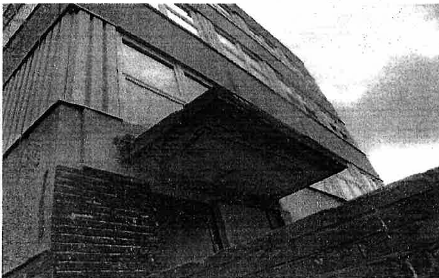
Foto nr 52 . Brak pokrycia i obróbkę blacharskich daszku.
