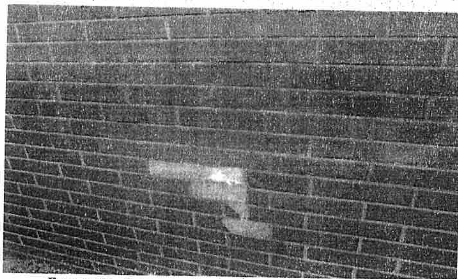
Foto nr 51. Odparzone i odpadnięte płytki cokołowe.
