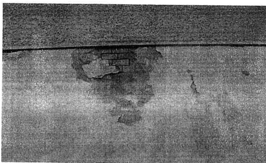
Foto nr 44. Odpadające tynki elewacji.
