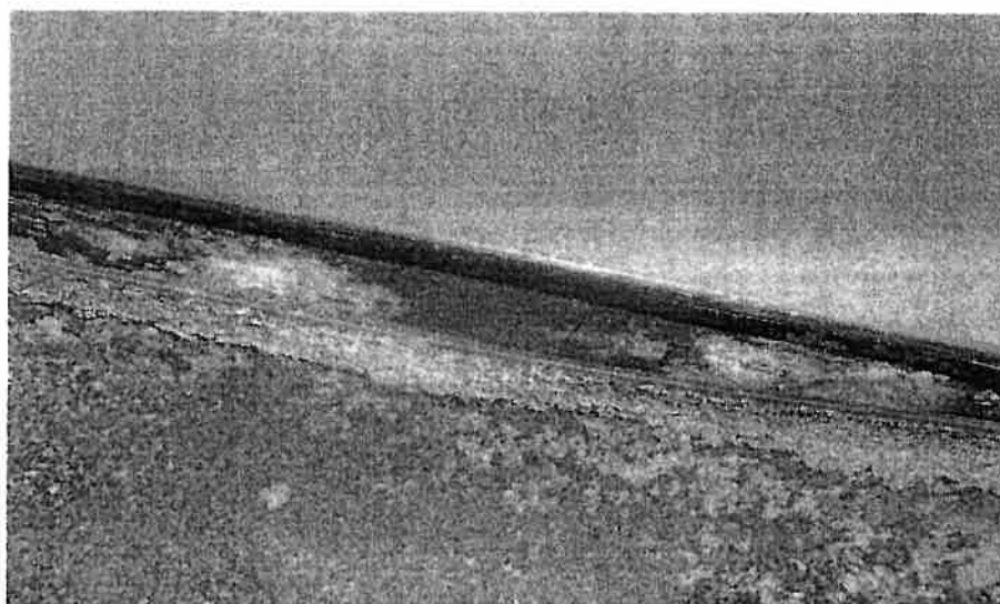
Foto nr 6. Odspojona papa od podłoża.
