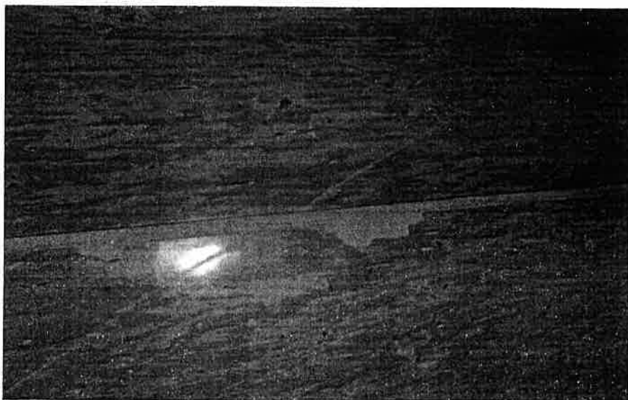
Foto nr 28 . Uszkodzone wykładziny PCV w korytarzu.
