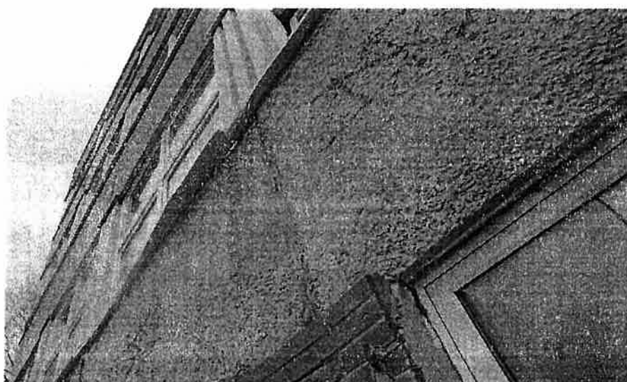
Foto nr 53. Luźne i odpadające parapety blaszane .
