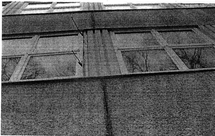
Foto nr 43 . Brak odpowiedniego uszczelnienia okien.
